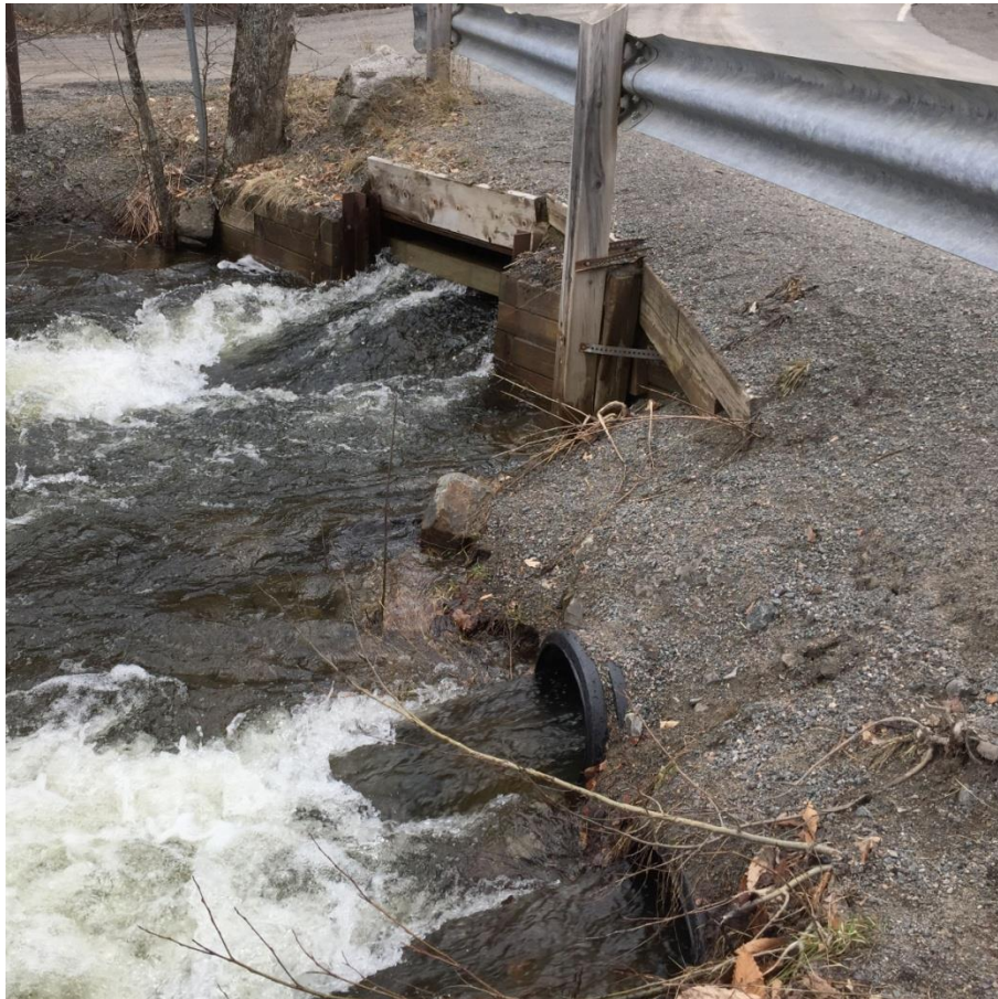
Figure 5. Vue du barrage du lac Ouimet (17 avril 2017) montrant au premier plan les sorties des deux ponceaux secondaires. Noter que la capacité d'évacuation du barrage, tout comme celle du ponceau principal (figure 4) semble saturée.
